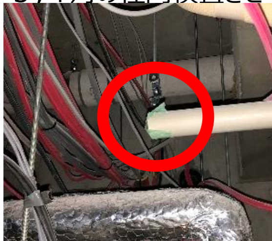
①引渡前日社内検査 (撤去後管末処理未施工)
