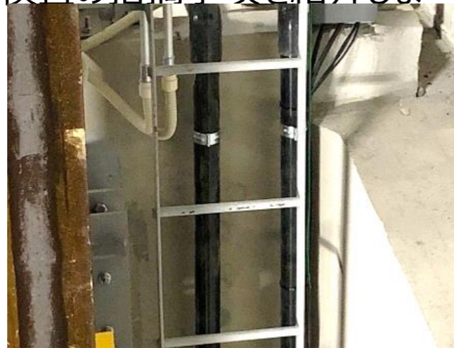
②HIVP排水ポンプアップ配管 (差込標線無)
